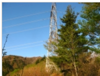
3つ目の送電鉄塔
